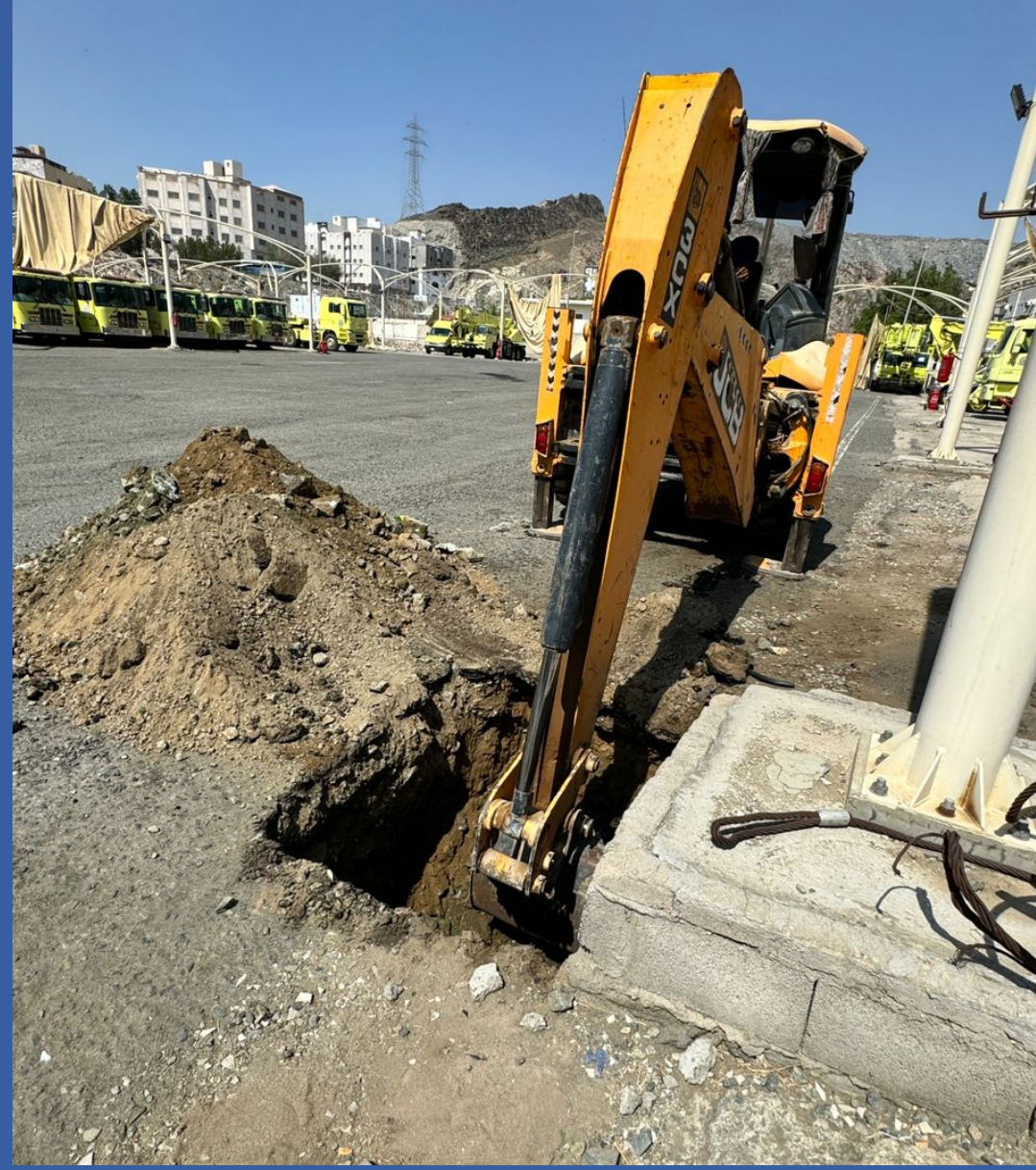
مشروع تطوير البنية التحتية لمقرات وزارة الداخلية
